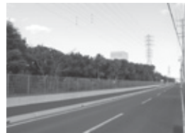
▲村田機械南側冠水対策
